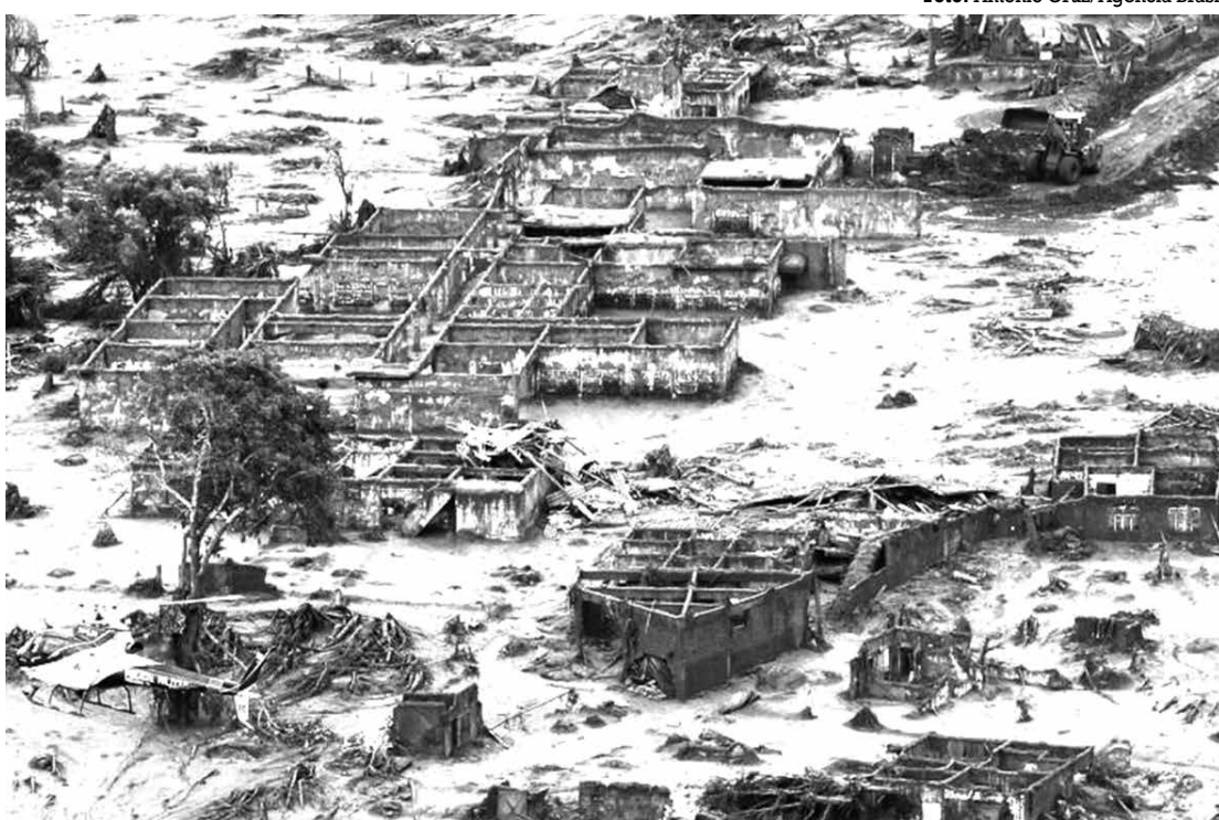
Imagem registrada posteriormente ao acidente exhibe os detalhes do que restou da antiga cidade
